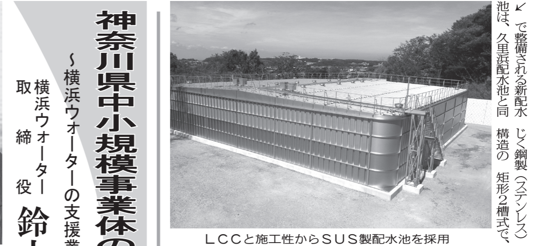
LCCと施工性からSUS製配水池を採用
