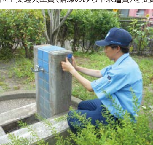
給水装置工事を完了した検査業務の作業風景
