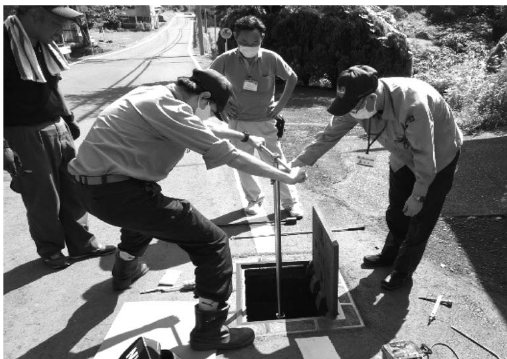
横浜ウォーター社員と漏水調査
